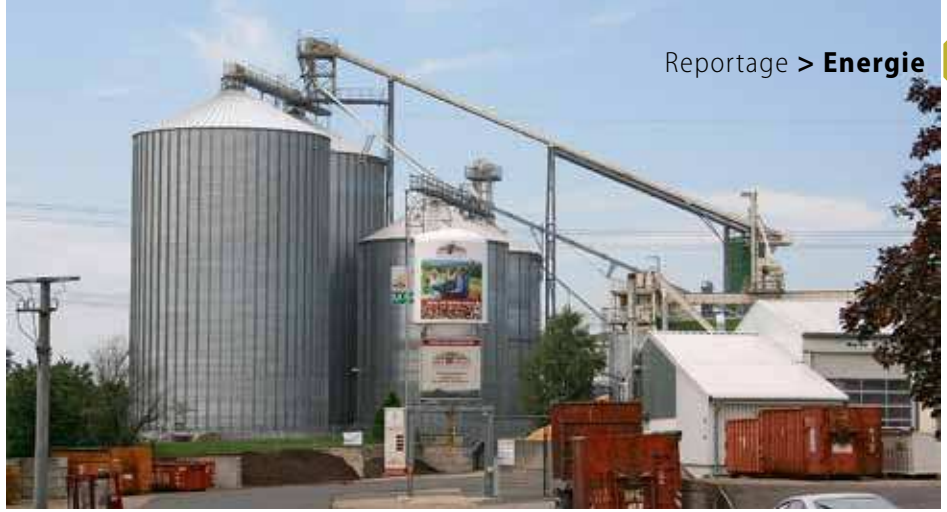
Produktionsstandort in Langenbach: 42.000 t/J werden gefertigt, ein Viertel der Menge wird in den vier Silos gelagert – im Vordergrund die automatische Pelletstankstelle mit dem Silo
