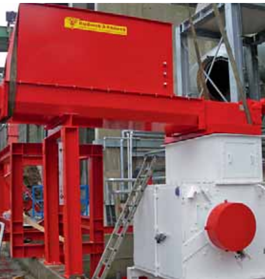
Montag der Dreifachförderschnecke RE-TFS 300 oberhalb der schneidenden Nassspanmühle
