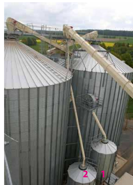
Komplexe R & E-Mechanisierung: Transport zum Verlade- (1) und Fehlchargensilo (2)
