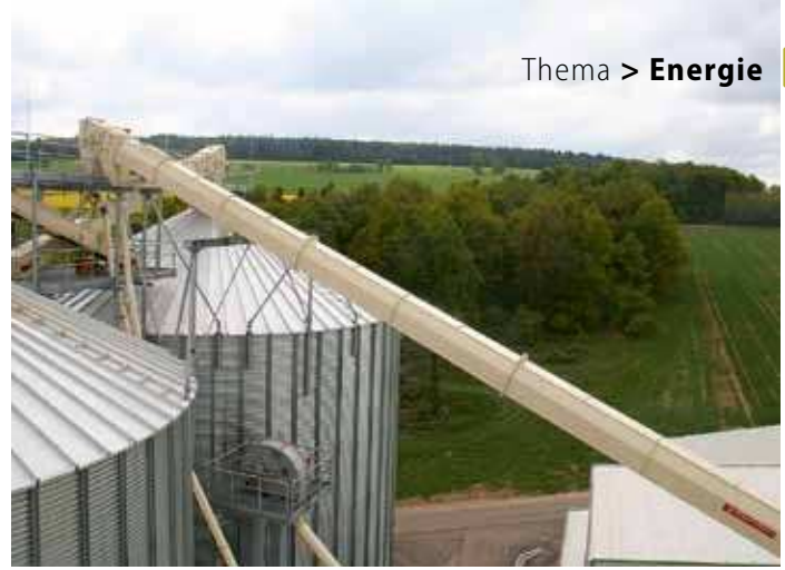
Neue Fördertechnik von Rudnick & Enners: Die Pellets gelangen über Rohrgurtförderer nach oben – es folgt die Verteilung auf die beiden Lagersilos
